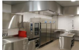
Mehrzweckhalle, Progy Rebstein
